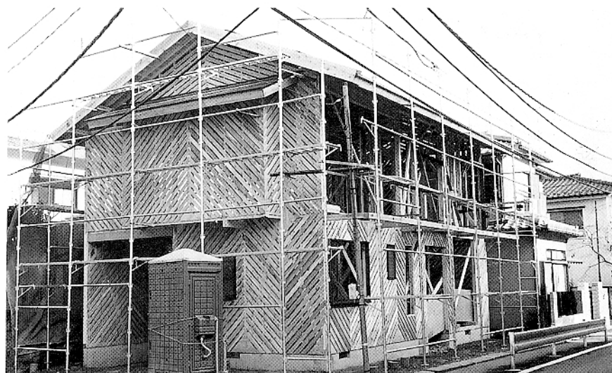
▲TIP構法による外壁下地板張り完了
